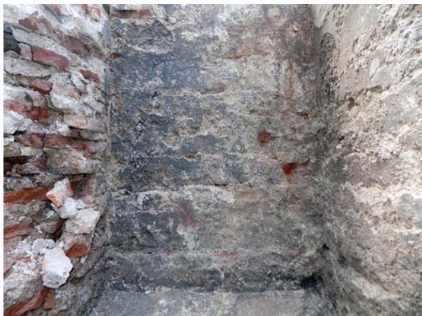
Обр. 13. Общ поглед към участък със запазен мазилков грунд – детайл (снимка: В. Цветков).
